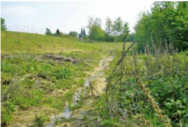
Abb 2: Zulaufgraben Hibernia im Bereich der Flottmannbrache
