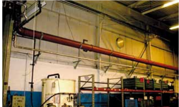
Fa. Spicer: neue Regenwasserleitungen in der Halle
