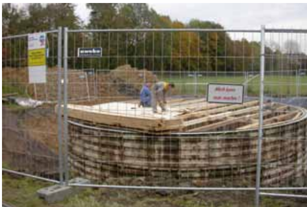
Fa. Artech, Bau der Regenwaserzisterne
