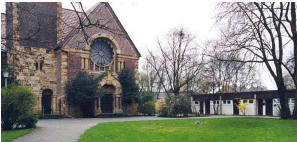
Abb. 1 Markuskirche in Oberhausen, Freifläche vor der Kirche als Mulde genutzt
