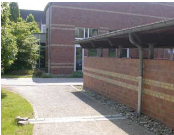
Abb.4 Christophorus Werk in Duisburg, Wegequerung mittels Kastenrinne
