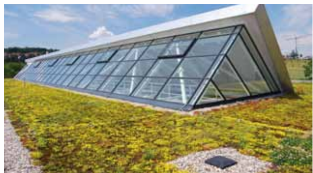
Abb 3: Extensive Dachbegrünung mit blühendem Mauerpfeffer
